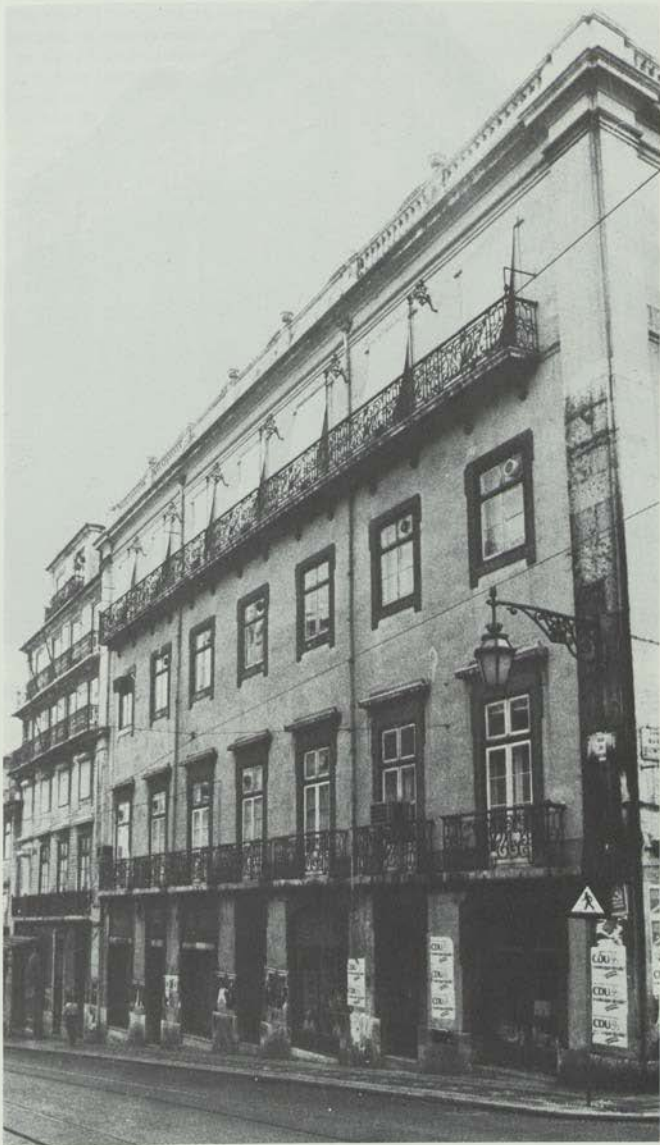
9 - «Assembleia Britânica» (1783), fachada principal. No piso térreo (entrada das «lojas» reservadas a uso do proprietário, Marquês de Marialva), bem como no andar nobre, é visível a fidelidade à Reconstrução pombalina (cf. EST. 7)
