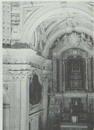
Vista lateral do interior da igreja do Menino-Deus, onde ressalta uma das capelas, num conjunto expressivo de planos e volumes, valorizando suavemente as massas, criando uma irradiação de luz, que passa através do óculo
