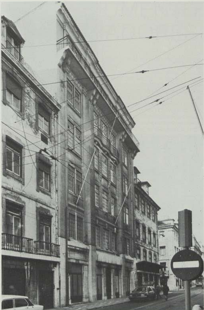
Casa da Rua dos Fanqueiros, n.º 9, com a fachada modificada, onde, no 3.º andar, residiu a família Verde antes de ir para o Salitre.
