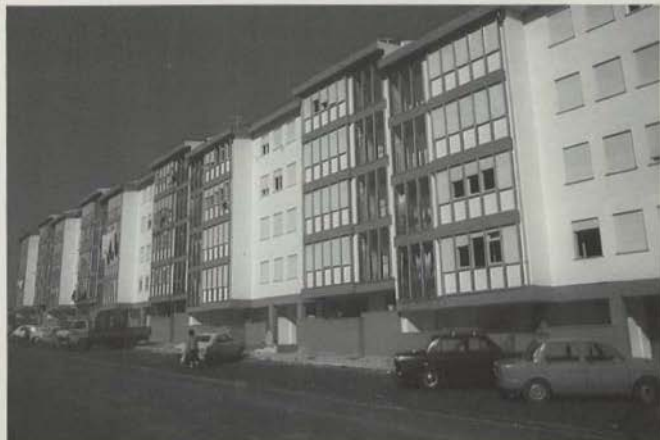
Pormenor de construção de habitação social em Chelas
