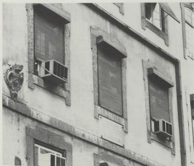
Pormenor (do lado da Rua da Madalena) do prédio reproduzido na ilustração anterior. À esquerda, o brasão dos Carvalhos (está também implantado na fachada da Rua dos Fanqueiros e na Rua da Alfândega). Mais para a direita, lápide comemorativa do nascimento de António Enes
