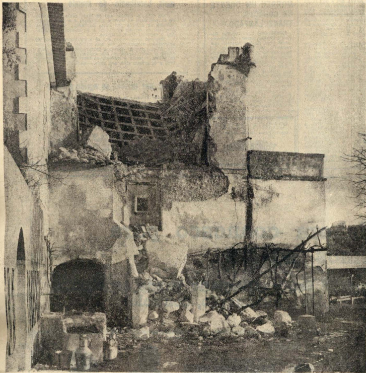
Em uma construção precária: o clássico adobe dos Árabes, com argamassa pobre em argila. Sob estes escombros morreu um homem. Aconteceu em Lagos, na madrugada do dia de Fevereiro.
