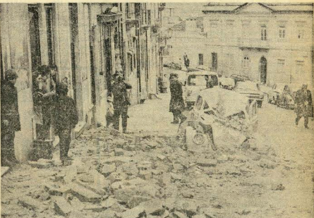
Aqui e além, um pouco por toda a cidade, os olhos inquietos do lisboeta descobriam, esta madrugada, os estragos que os prédios já velhos ou de má construção não resistiram ao forte abalo e as vítimas foram, neste caso «concretas», os automóveis estacionados ali perto...
