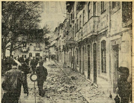
Algumas das ruas da capital sadina ficaram cobertas de destroços
