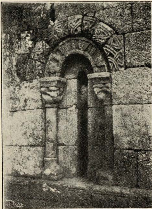
FIG. 4 — JANELA DA PARTE ARCAICA DO EDIFICIO
