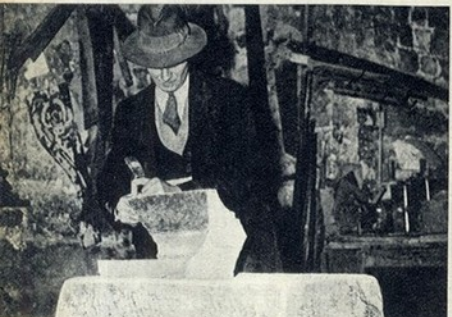
Um canteiro trabalha numa peça de pedra de Portland para reparar um defeito
