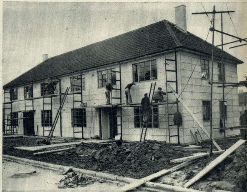
A montagem de uma casa pre-fabricada, para vários inquilinos
