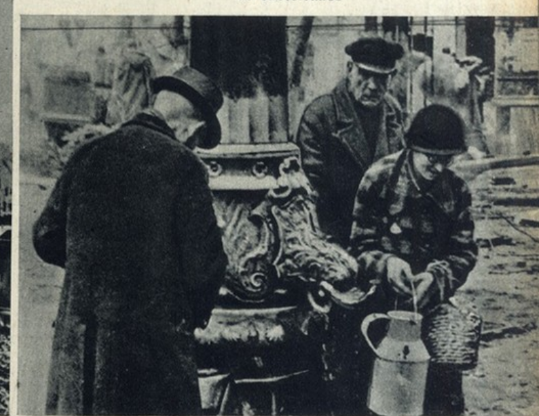
Durante os primeiros dias de ocupação, quando os serviços de água ainda não estavam reparados
