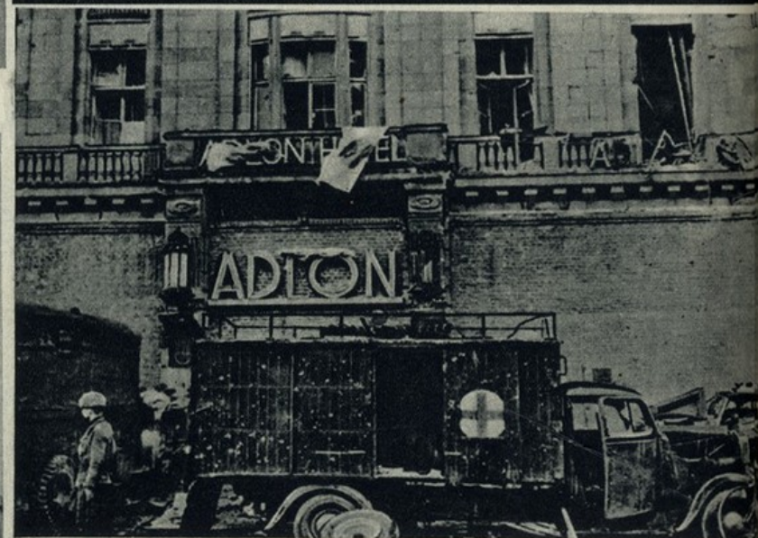
O famoso hotel Adlon, na Unter den Linden, que foi atingido pelas bombas da aviação aliada
