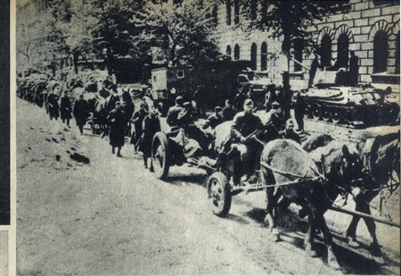
Fôrças de Artilharia atravessando uma das artérias da capital, onde se vêem alguns prédios intactos
