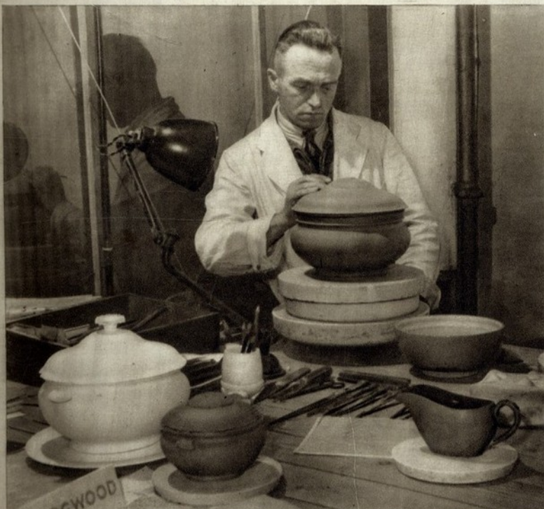
Ainda é a habilidade manual factor de grande importância na cerâmica. Um operário especializado modela uma terrina
