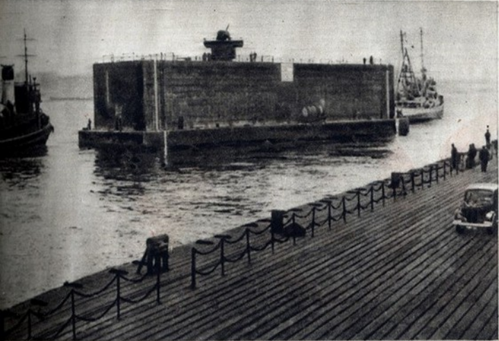
Um dos elementos básicos são estas torres flutuantes, que servem, ao mesmo tempo, de cais e de posições de artilharia anti-aérea
