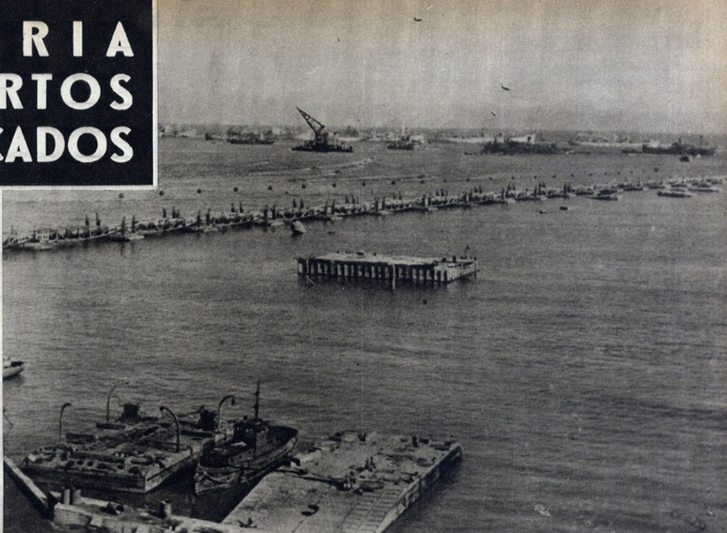
Uma vista geral do porto artificial instalado em Arromanches, maravilha técnica, inspirada por Churchill, que assim liga o seu nome àquela concepção, como na outra guerra - o ligou à invenção do tank
