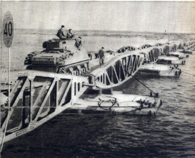
Estes formidáveis chassis de aço, montados sobre pontões, constituem verdadeiras estradas sobre as quais passa material pesado, como este tank
