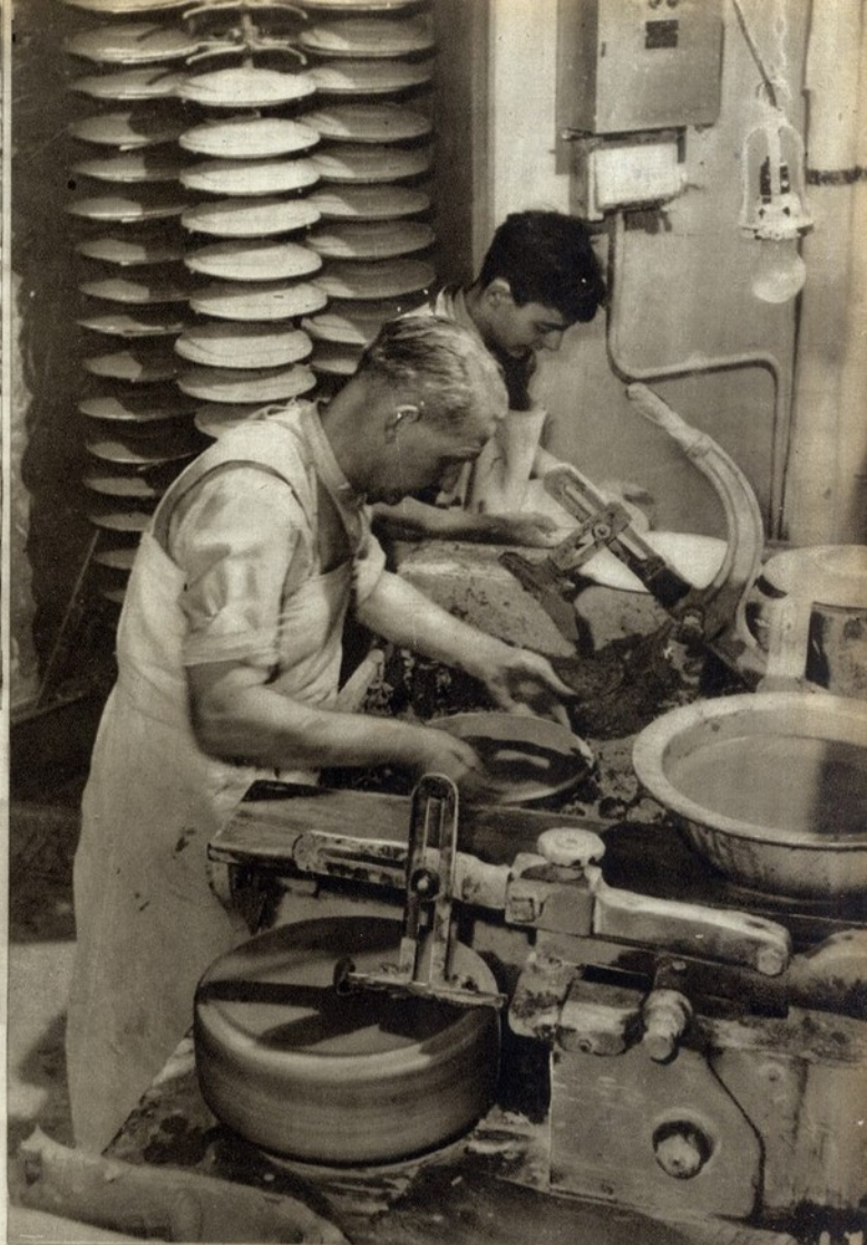
O fabrico de pratos em série. Procede-se à última operação antes de introduzir os pratos no forno eléctrico
