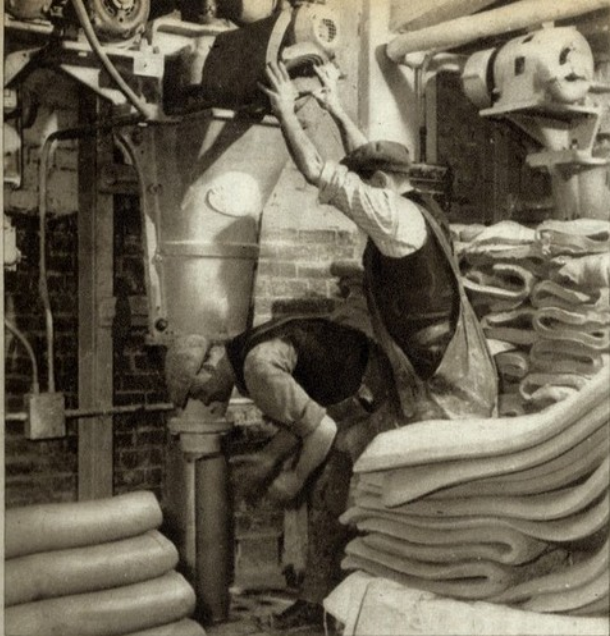
Este maquinismo transforma placas de porcelana em cilindros. Dois operários chegam para manobrá-lo
