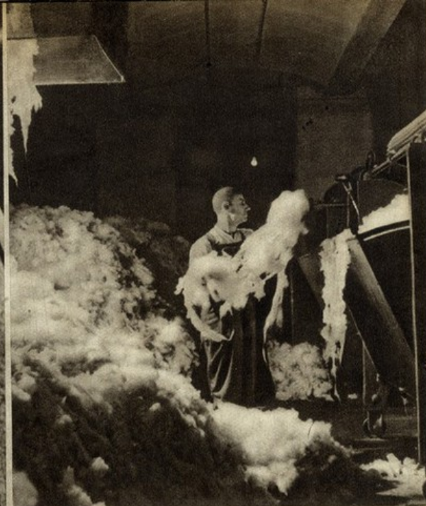
A cardadora. Os flocos brancos de lã vão ser reduzidos a fios
