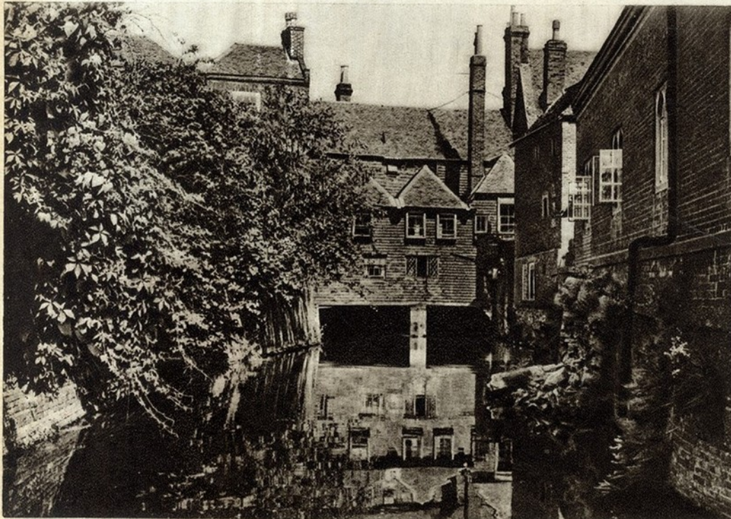
Esta é a velha hospedaria dos peregrinos, construída há mais de 750 anos. Bombas alemãs caíram muito perto, durante a Batalha de Londres
