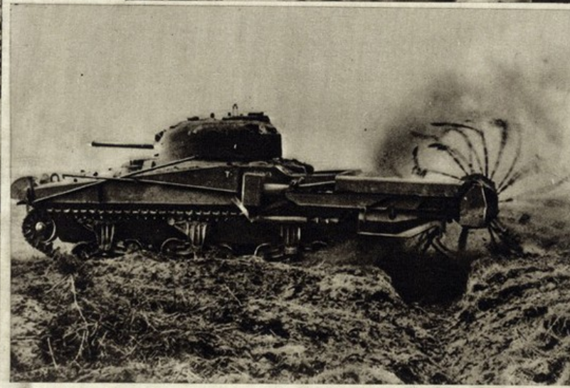
Uma nova arma britânica. Este tank tem um dispositivo especial que lhe permite limpar o terreno das minas
