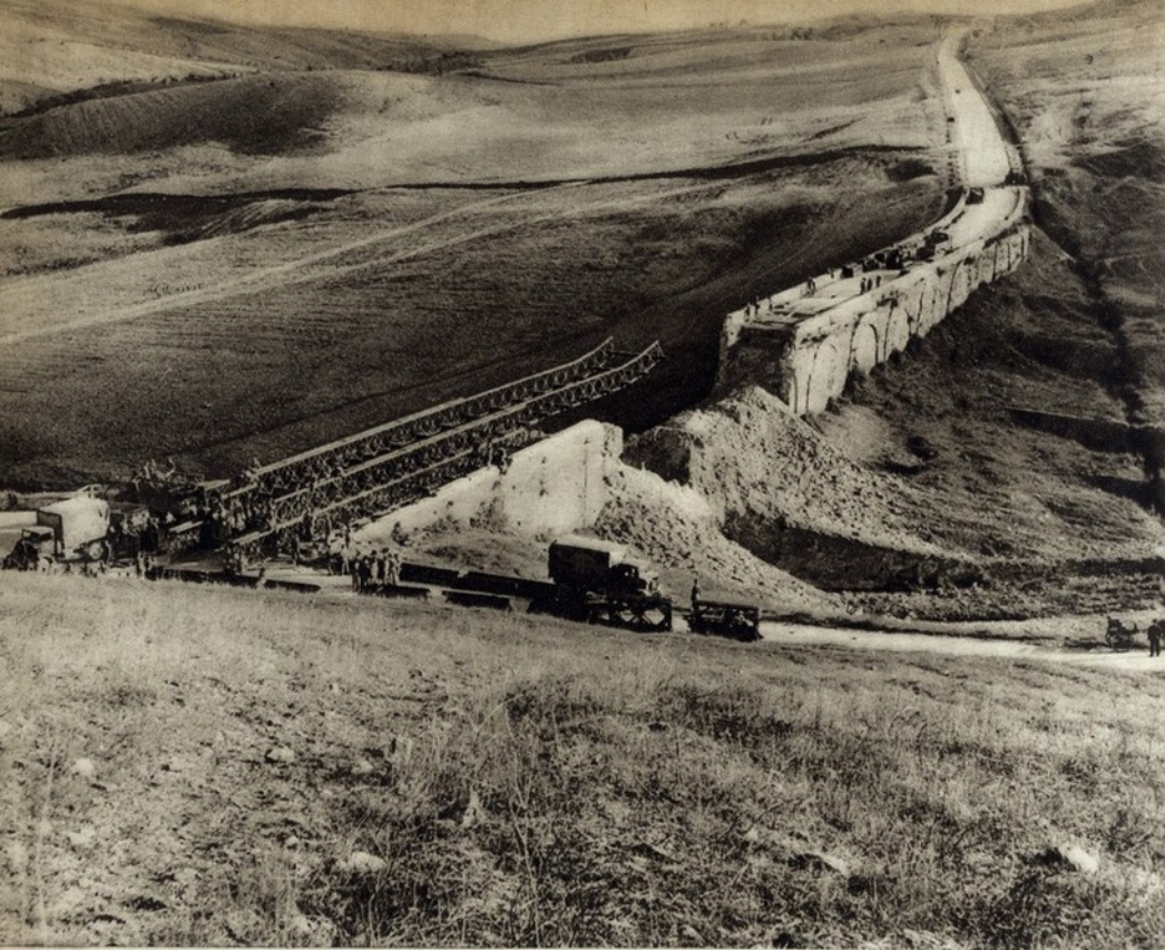
A ponte Baley, que permite a passagem de qualquer rio, até 50 metros de largura, sem auxílio de pontões. Desmancha-se em secções de três metros de comprimento e a parte mais pesada pode ser transportada por seis homens. Montgomery considera-a a melhor que existe
