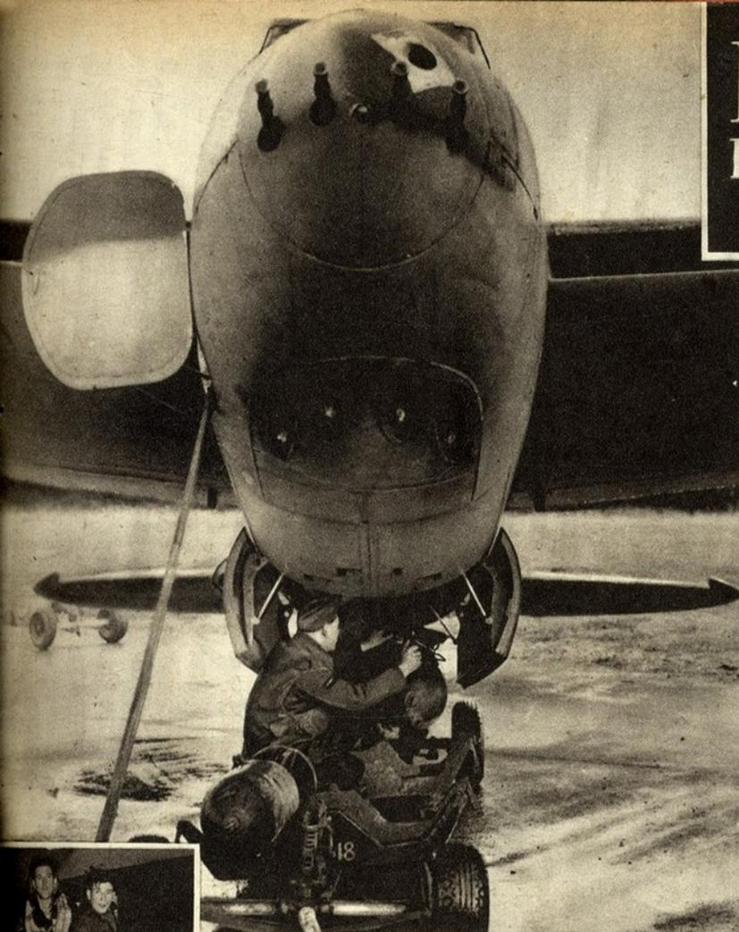
O novo «Mosquito» cujo potencial de fogo é terrível. Possui quatro canhões de 20 milímetros e quatro metralhadoras, transportando ainda bombas com o peso de mil quilos
