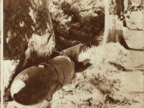
Este truque alemão não deu resultado. Cada árvore desta estrada tinha uma bomba ligada electricamente
