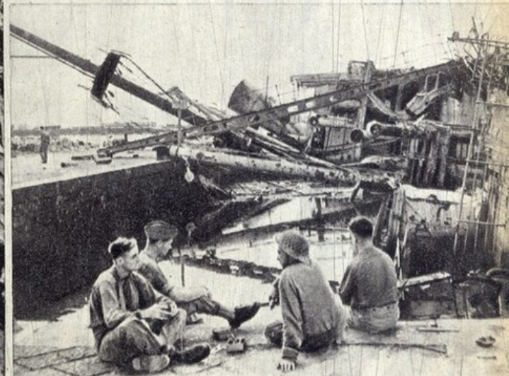
Uma visão do porto de Nápoles. Tudo isto já desapareceu. Os serviços de engenharia do Exército anglo-americano repararam rapidamente o porto
