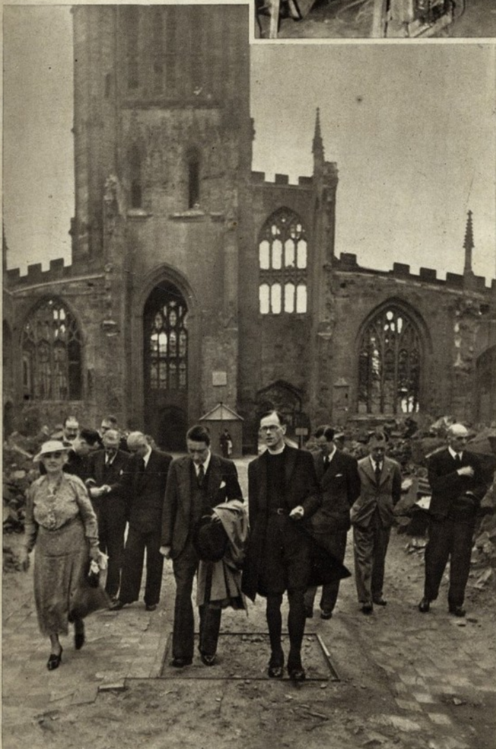
Gravemente, o sr. dr. Armino Monteiro inclina-se sôbre as pedras sagradas da catedral de Coventry, que a aviação inimiga converteu em ruínas atingindo os símbolos das liberdades espirituais
