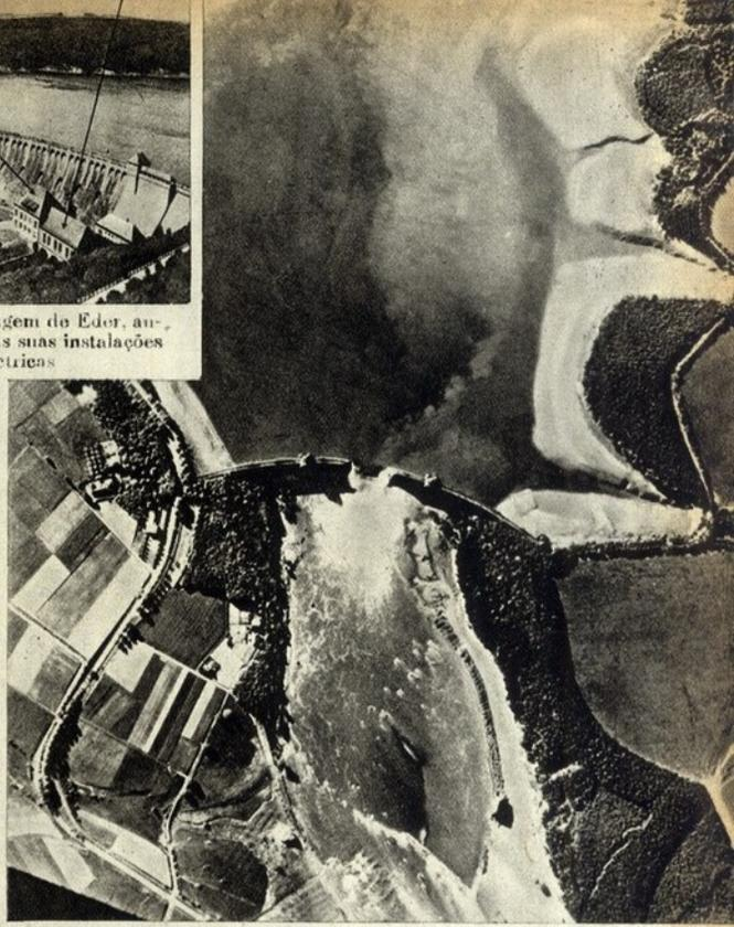
Esta é a barragem do Mochne, depois da sua rotura. Apesar da altura a que estas fotografias foram obtidas, pode verificar-se como as águas através da brecha, que tem pelo menos cem metros de extensão, invadem impetuosamente os terrenos e, num caudal gigantesco, submergem tudo
