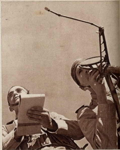
O comando transmite uma mensagem com o heliografo, pelo sistema «Morse»
