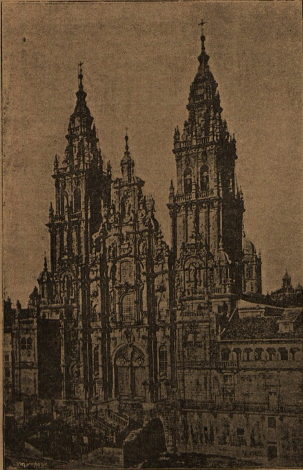
FACHADA PRINCIPAL DEL OBRADORO
