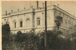
O antigo edificio da Embaixada alemã em Lisboa, na Rua Pau de Bendeiro, onde há tempos houve um incêndio, e que vai agora servir de residência particular do sr. Embaixador dos Estados Unidos.
