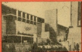
Amsterdão, tão trágicamente atingido pela guerra, não era só uma cidade importante pela história e pelo papel que representava no comércio, pois possuía importantes edifícios como este Estádio, planeado e executado pelo architecto Jon Wils.
