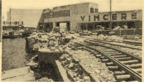
Uma estação do caminho de ferro quasi ficou destruída pelo efeito das bombas. Quanto tempo levará agora a restaurar tudo isto?
