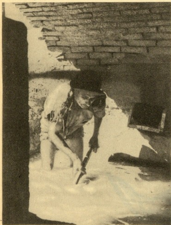
Dentro do tanque, com a água pelos joelhos, o trabalhador amassa o barro.
