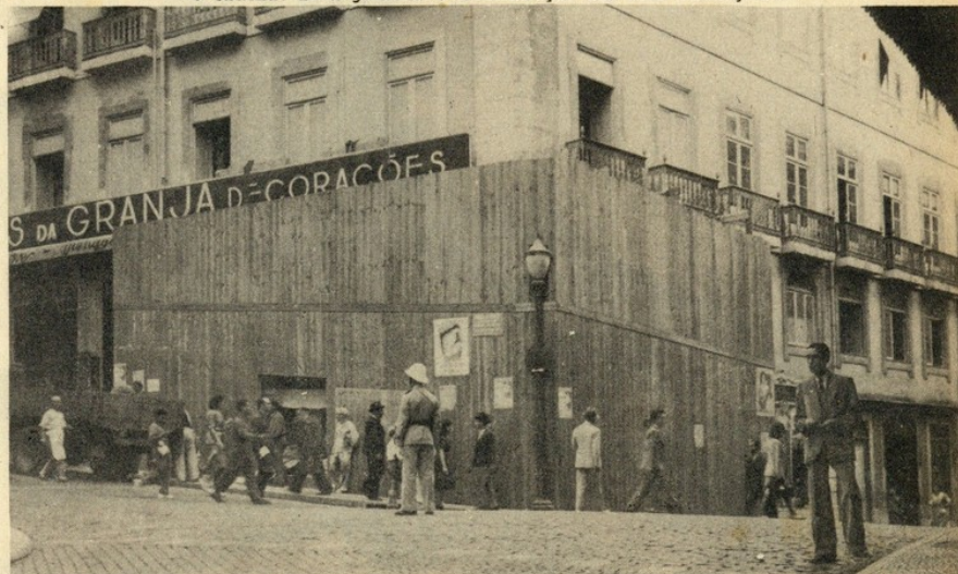
No Chiado, à esquina da Rua do Carmo. Aqui era uma loja de chapéus — o Salão Cardoso. Está em obras para a instalação, ao que nos dizem, de um moderno «stand» de propaganda dos serviços alemães de turismo...
