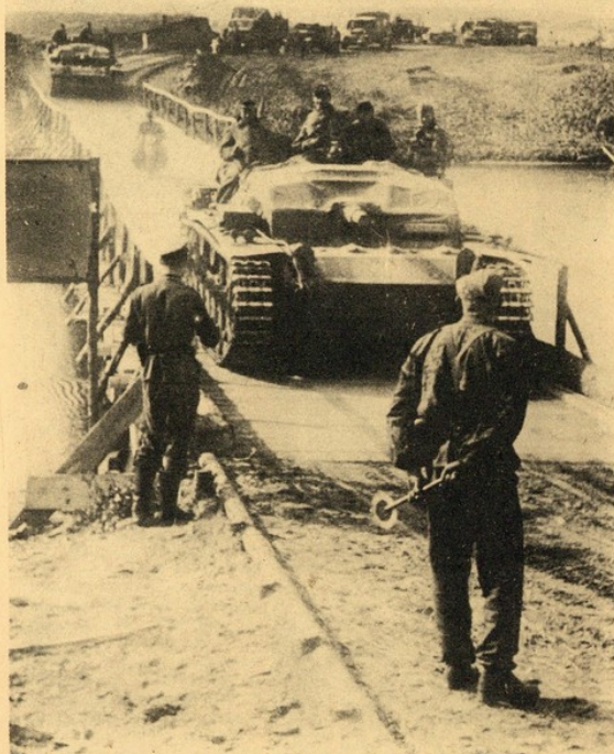
DOIS ASPECTOS DA LUTA NA REGIÃO DO DONETZ: Trabalhos de construção duma estrada—Uma coluna motorizada alemã avançando por uma ponte construída rapidamente pelos pontoneiros do Reich.
