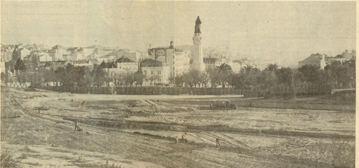
ASPECTO PARCIAL DAS OBRAS DE URBANIZAÇÃO do Parque Eduardo VII que estão a executar-se segundo o projecto Cristino da Silva. A foto mostra-nos o sítio onde até agora existia o lago. Através dêsse local vai-se rasgar uma avenida que ligará a Rotunda do Alto do Parque, em prolongamento da Avenida da Liberdade.
