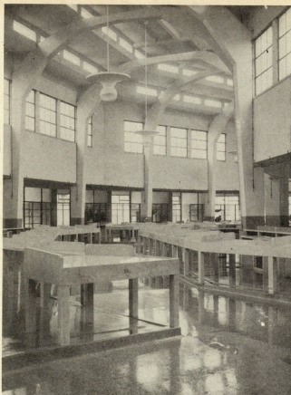
ASPECTO DAS MAGNIFICAS instalações do novo mercado de Arroios, inaugurado recentemente
