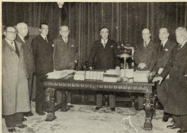
O SR. MINISTRO DAS OBRAS PÚBLICAS, com os representantes da Companhia das Águas de Lisboa e outras individualidades que assistiram à assinatura do novo contracto de abastecimento daquelle líquido à capital e arredores.
