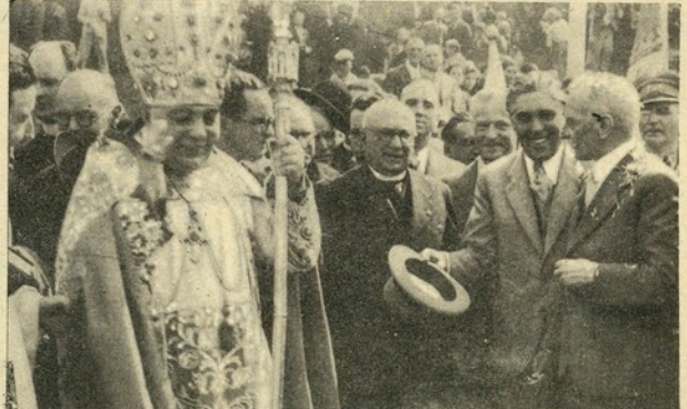
O SR. BISPO DO PÓRTO lançando a bênção sobre a ponte «Duarte Pacheco».
