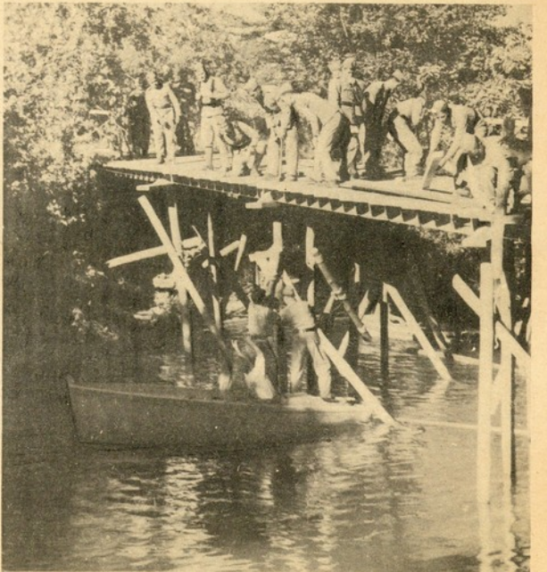
OS SAPADORES MINEIROS improvisam uma ponte sobre o rio Leça, próximo da Ponte da Pedra, para facilitar a evacuação da população.
