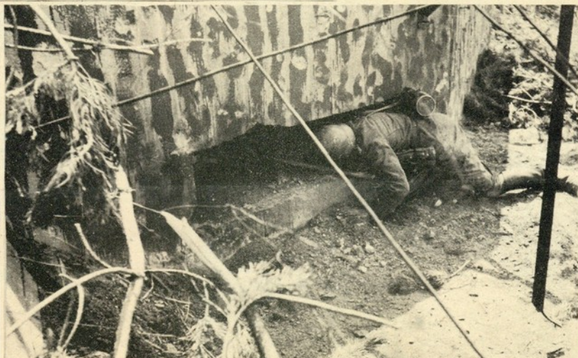
UM SOLDADO INSPECCIONA, com precaução, um dos fortins da Linha Estaline posto fora de combate e depois conquistado pelas forças de choque alemãs. O fortim, construído em cimento, estava bem camuflado e poderosamente defendido por metralhadoras e duas peças de artilharia.
