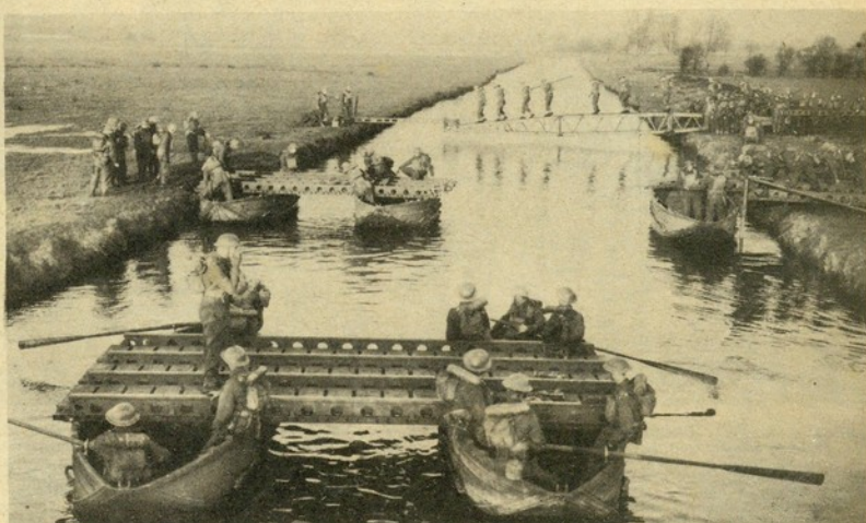
ENQUANTO A INGLATERRA ESPERA A INVASÃO, as tropas britânicas de engenharia fazem exercícios de transporte de tropas em pontes improvisadas, destinadas a ser utilizadas em território inimigo. As pontes podem ser lançadas numa grande extensão e dão vazão a grande número de soldados de infantaria, permitindo, também o transporte de armamento.
