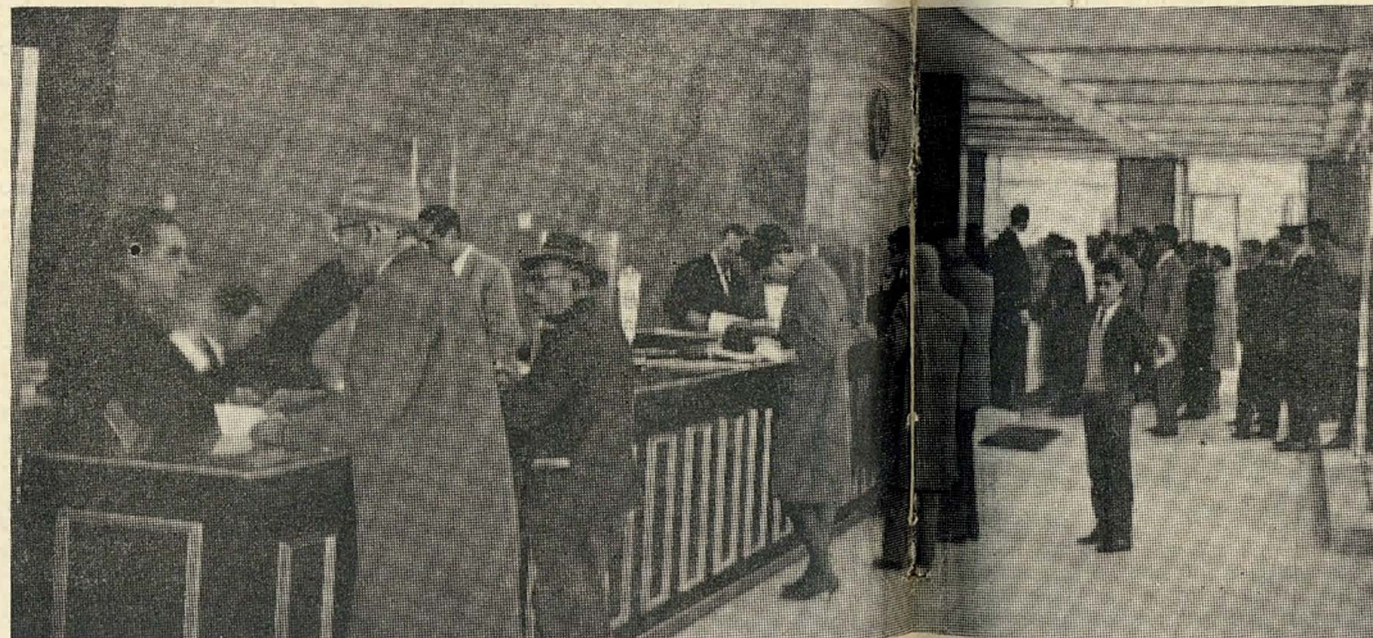
Um aspecto da sala do Banco Pinto & Sotto Mayor depois da recente remodelação
