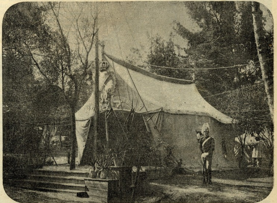
Barraca da commissão installadora
