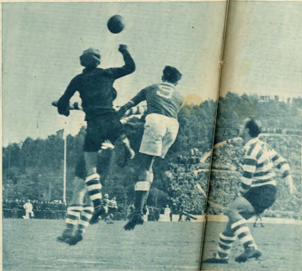
Azevedo e Águas estão no ar, com propósitos diferentes. A defesa faz-se!
