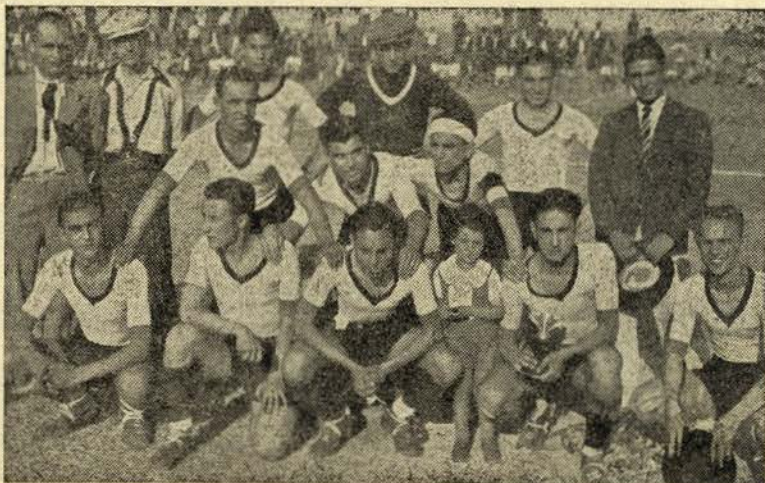
«O «team» vencedor do «Torneio da Margem Esquerda em 1942/43»
