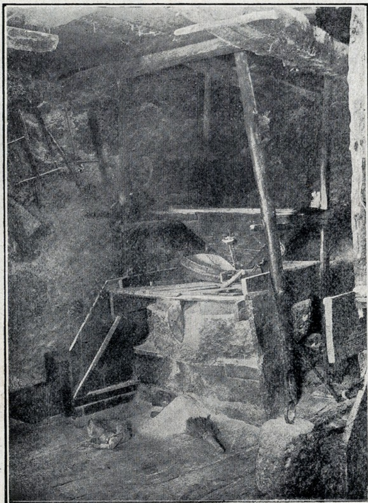
O MOINHO DE SECHO (VISTA PARCIAL)
