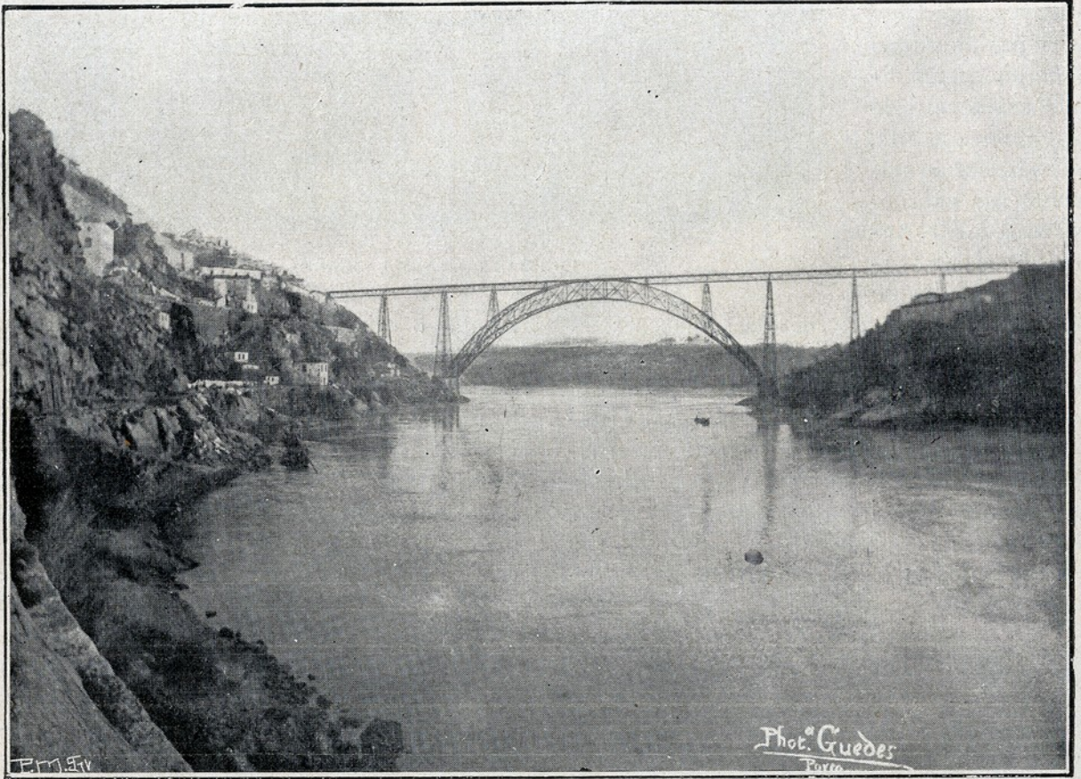
PONTE DE FERRO D. MARIA PIA
