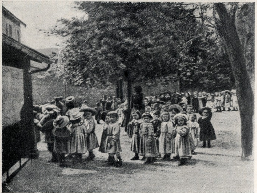
A ENTRADA PARA AS AULAS
