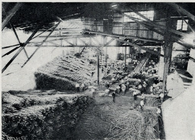
ENTRADA GERAL DA FABRICA DO TORREÃO E O ARMAZEM DAS CANNAS
