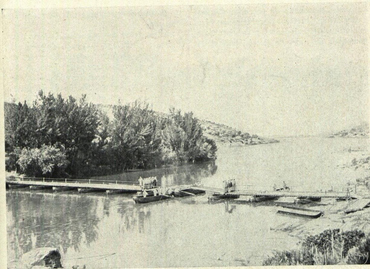
INSTRUÇÃO DE PONTONEIROS — SUBSTITUIÇÃO DE UM BARCO NUMA PONTE DE BARCOS DE EQUIPAGEM
