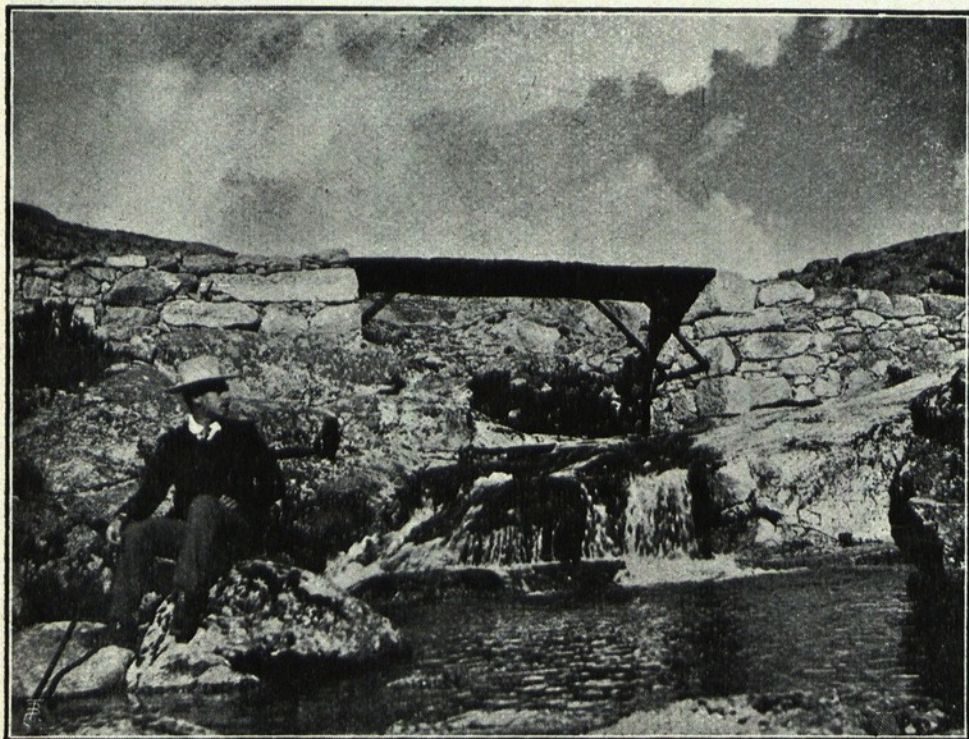
PONTE SOBRE A RIBEIRA DE CÓRTEZ
