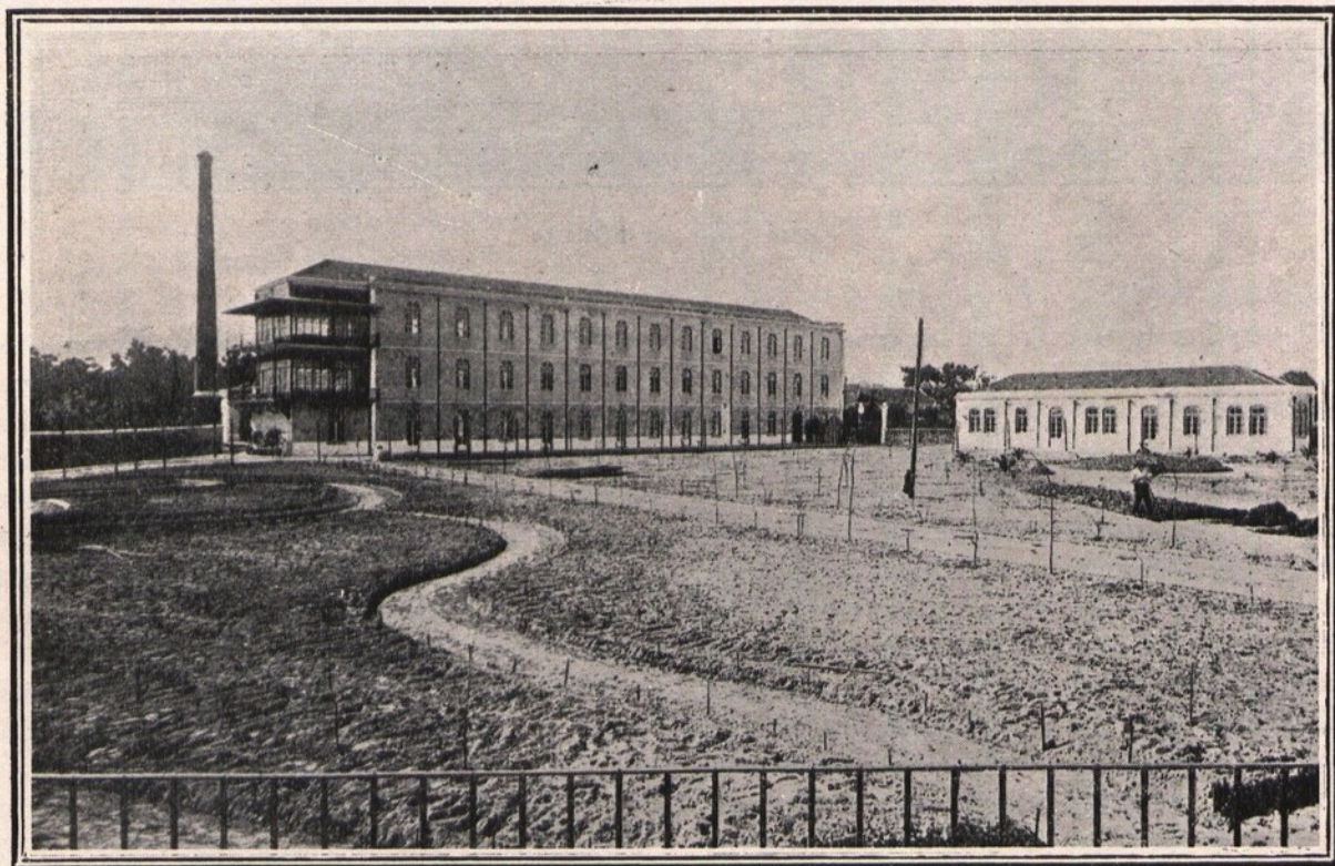
ENTRADA PRINCIPAL,—GRANDE ALA DO EDIFICIO DOS TUBERCULOSOS, E TERRAÇOS ENVIDRAÇADOS —SECÇÃO DE CONSULTA EXTERNA E SALA DE OPERAÇÕES
