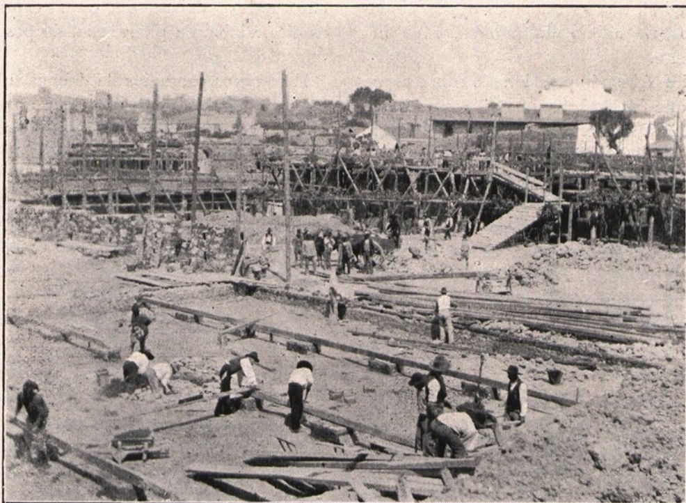
OBRAS PARA O NOVÓ HOSPITAL DE SANTA MARTHA
