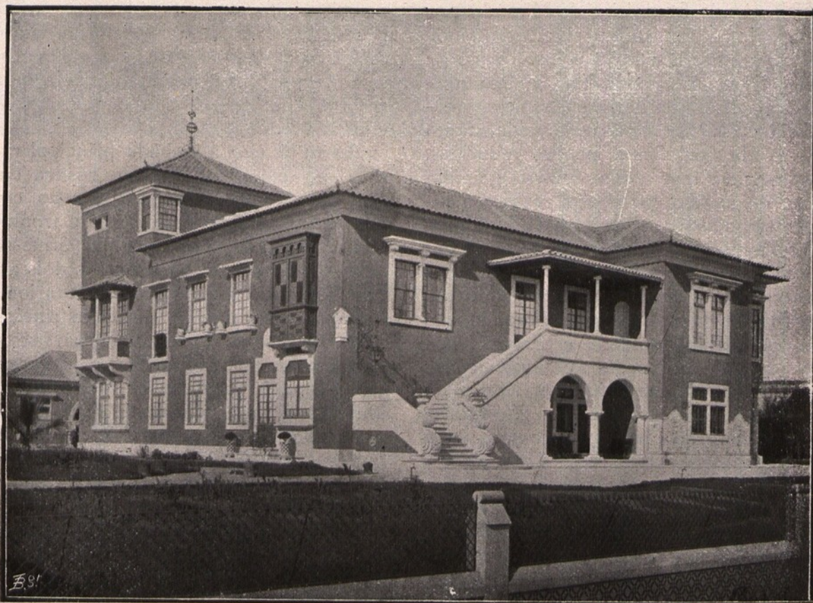
CASA DE RICARDO SEVERO NO PORTO—VISTA DO SUL
