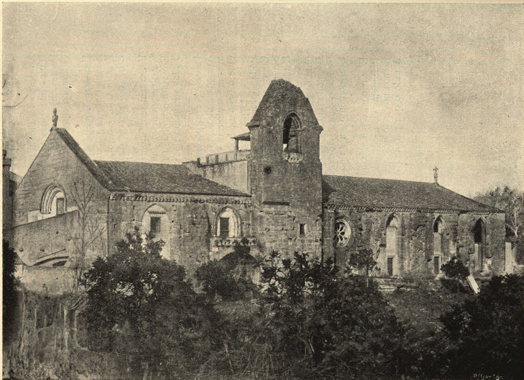
IGREJA DE SANTA CLARA A VELHA. — LADO MERIDIONAL E TOPO OCCIDENTAL DO EDIFÍCIO
