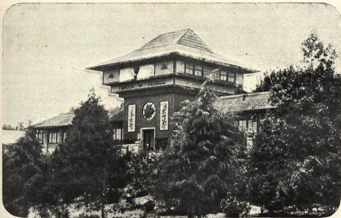
ASPECTO DA FABRICA DAS CALDAS DA RAINHA
