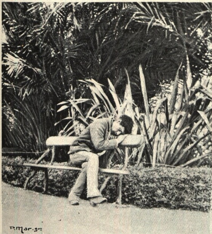
NA RUA DAS PALMEIRAS
