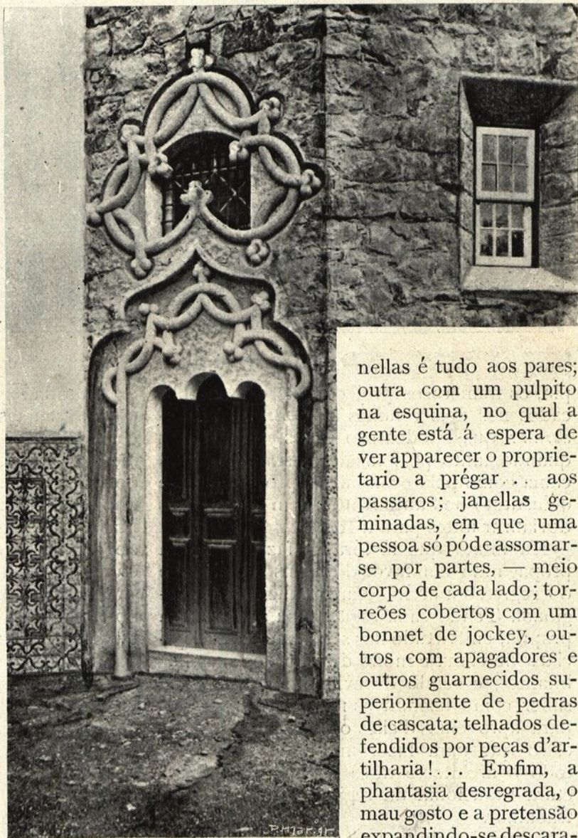
DETALHE DA PORTA DA TORRE
