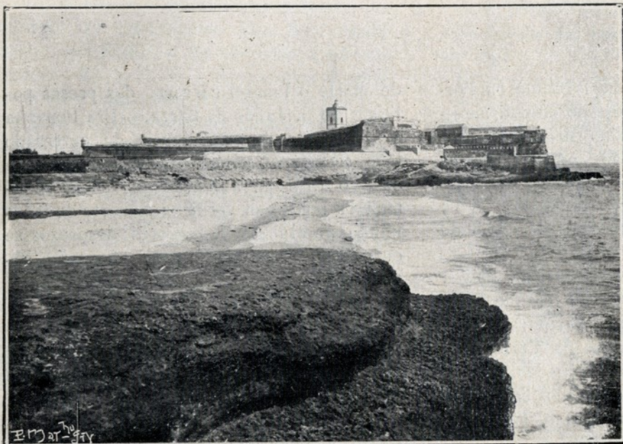
A TORRE DE S. JULIÃO DA BARRA VISTA DE OESTE
