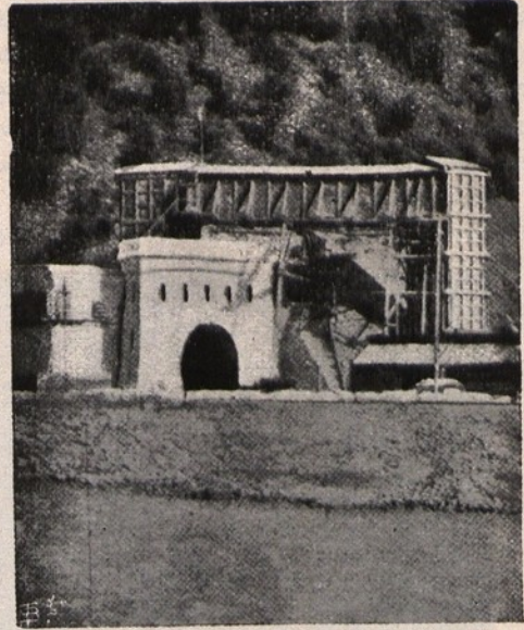
ENTRADA DO TUNNEL EM BRIEG
