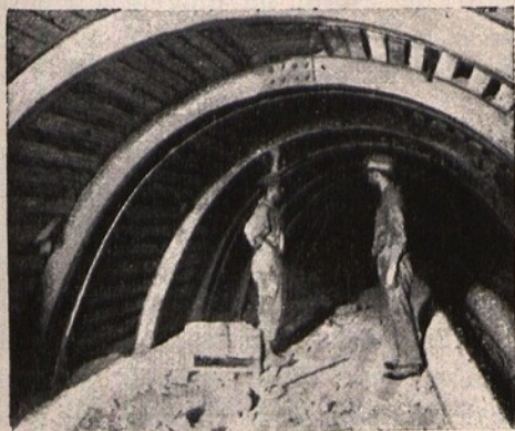
PARTE DO TUNNEL
