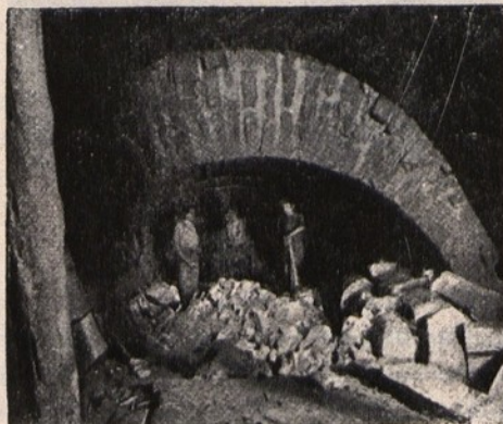
GALERIA DE VENTILAÇÃO
