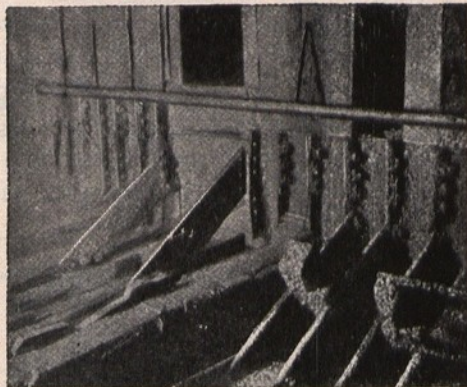
ARMADURA N'UM SITIO PERIGOSO
