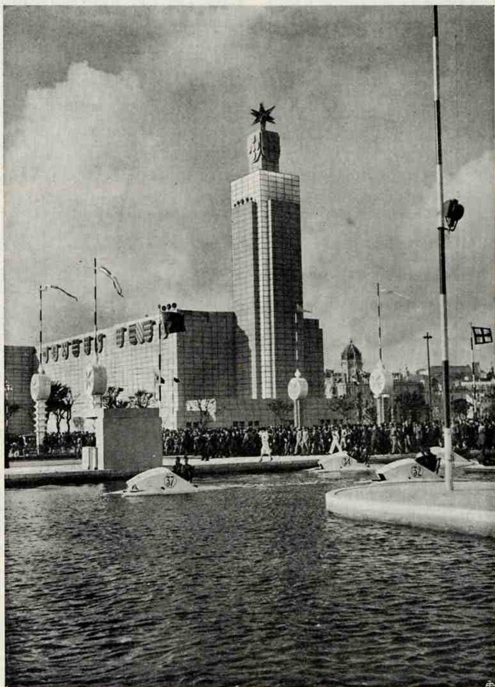
TORRE DO PAVILHÃO DOS PORTUGUESES NO MUNDO
