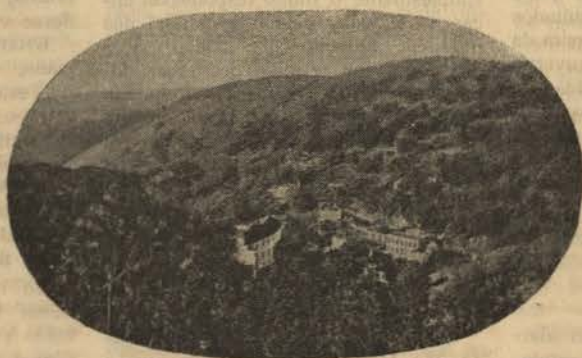
CALDAS DE MONCHIQUE—Vista geral
