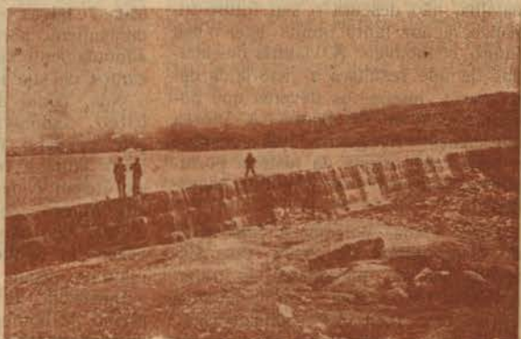
SERRA DA ESTRELA—GRANDE DIQUE DA LAGOA COMPRIDA, EM CONSTRUÇÃO
